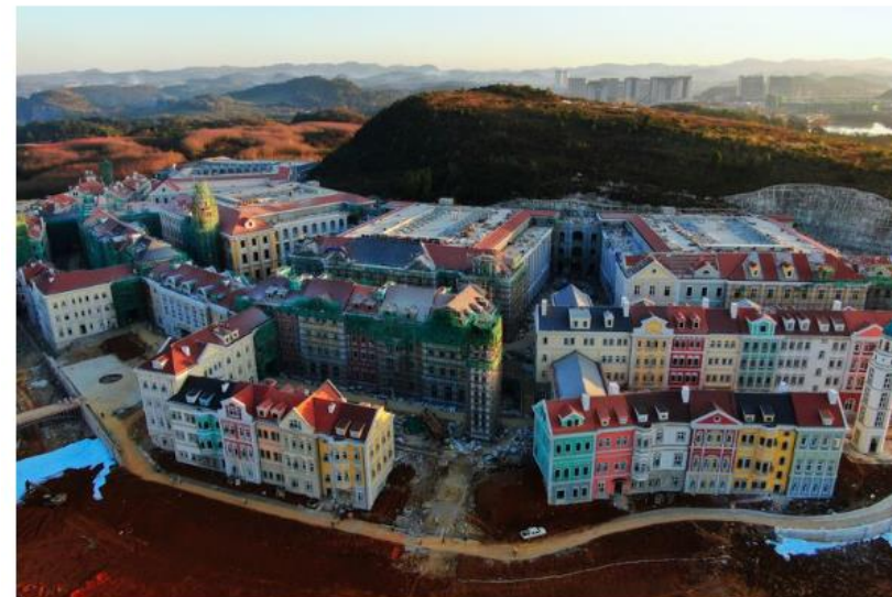
Het lijkt een historische stad, maar is een datacenter van de Chinese telecomgigant Huawei in Guiyang. Beeld Getty Images
