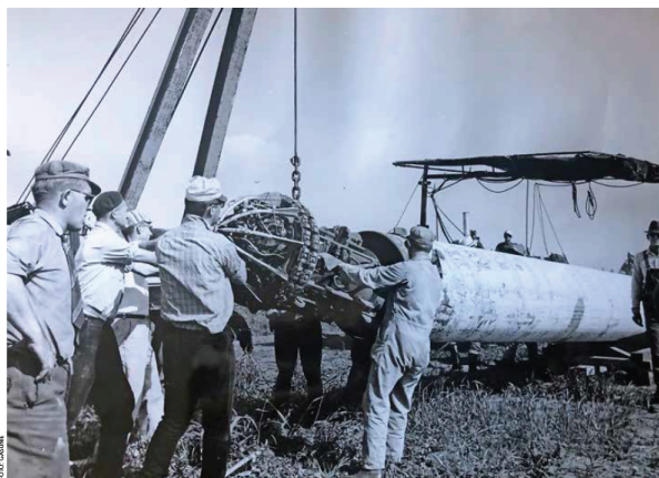
Aanleg van een gaspijp in de jaren zestig van de vorige eeuw. Om incidenten te voorkomen, moeten boeren bij graafwerkzaamheden van meer dan 50 centimeter diepte een melding doen bij het Kabels en Leidingen Informatie Centrum, zegt Hans Boels.
